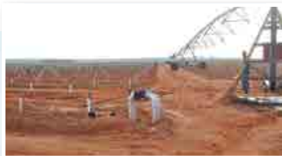
150 mm toevoerkrans om vir die 80 mm krane in die verskillende blokke water te voorsien.
