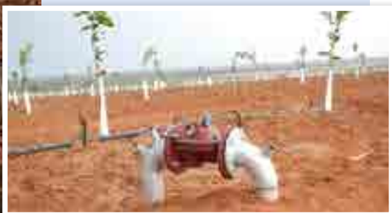
Verstelbare 80 mm kraantoewer vir die verlangde waterdruk en vloei.
